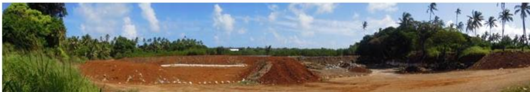
2013年2月の処分場全容（改善工事直後）
