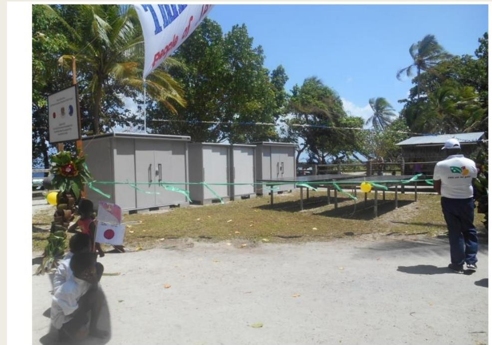
太陽光発電設備と海水淡水化設備棟（左の白い建物）
